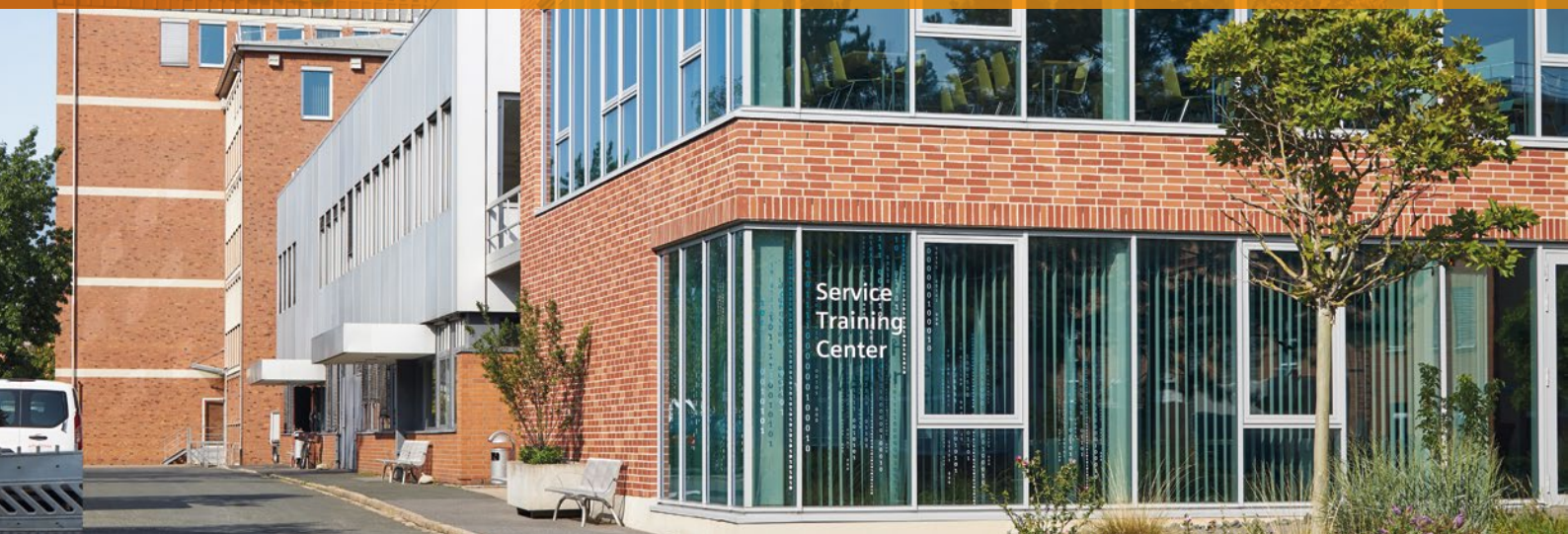
Siemens Technopark Nürnberg (Quelle: Siemens Real Estate)
